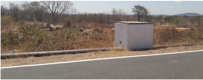
Fig. 9. Adutora emergencial de engate rápido Santa Cruz/RN - Pau dos Ferros/RN.
