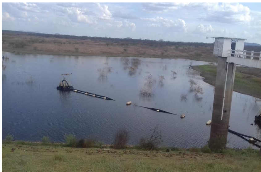
Figura 1: Barragem Pau dos Ferros/RN Fonte: Acervo dos autores (2018).
