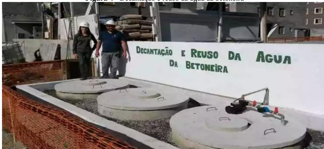
Figura 4 - Decantação e reuso da água da betoneira
