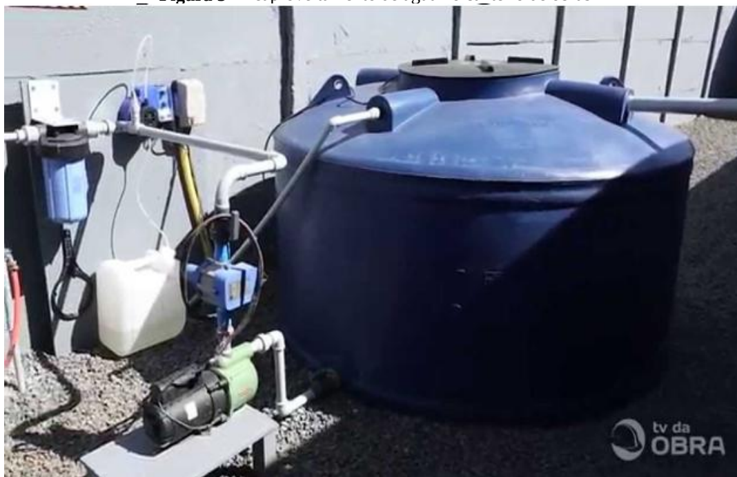
Figura 3 - Reaproveitamento de água no canteiro de obras
