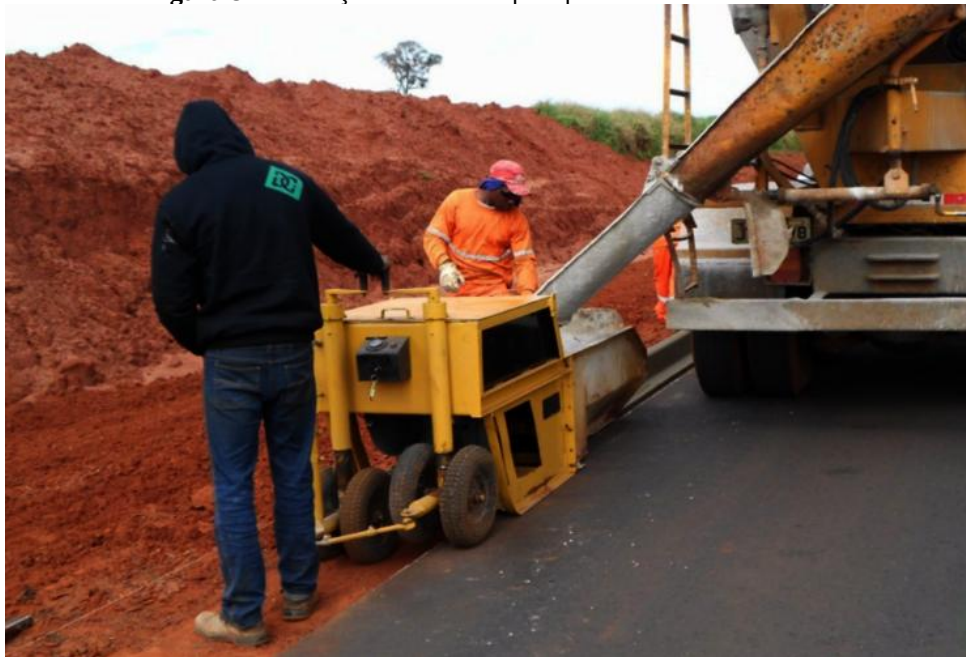
Figura 8 - Utilização de concreto para produzir meio-fio in loco
